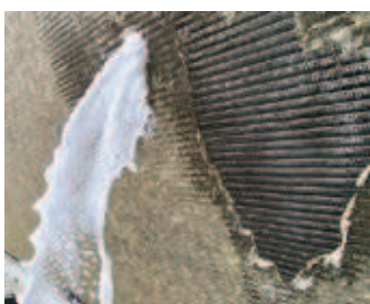
Nettoyage HP des condenseurs à air
