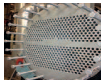
Rénovation des boîtes à eau des échangeurs
