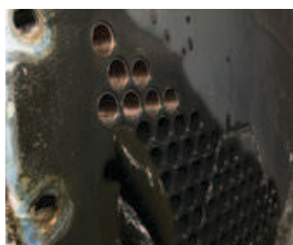
Nettoyage des tubes échangeurs noyés
