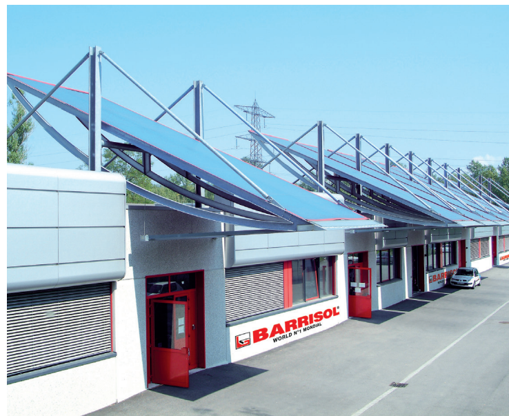
© Barrisol® - Site de production de Kembs - France
