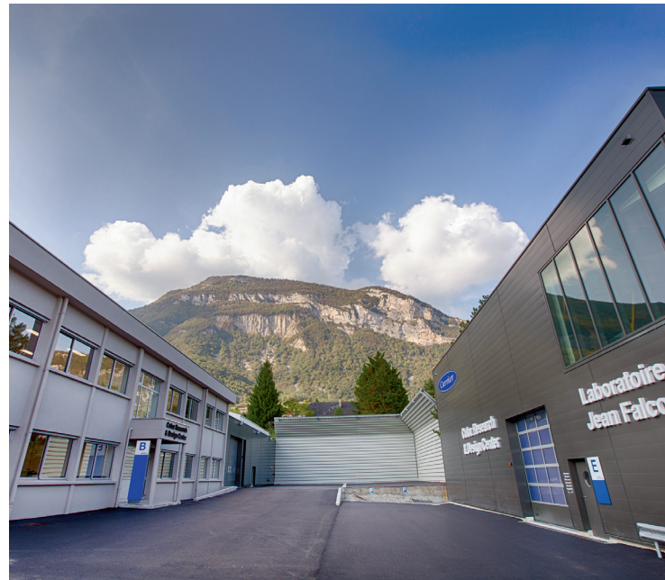
© CIAT® – Centre d'excellence du traitement de l'air à Culoz - France
